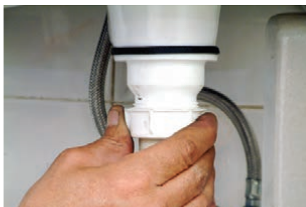
شکل ۳-۵۶ بستن مهره‌ی لوله‌ی عمودی سیفون به زیراب
