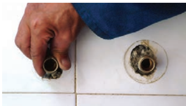
شکل ۱۸۴-۲- پیچیدن دنباله‌ها به محل نصب شیر
