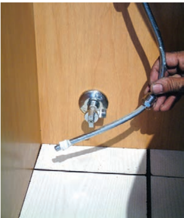
شکل ۳-۲۵۵- خمکاری لوله‌ی پیسوار
