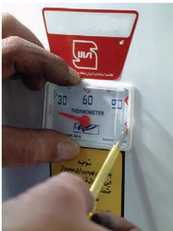
شکل ۱۱۶-۱ جدا کردن ترمومتر
