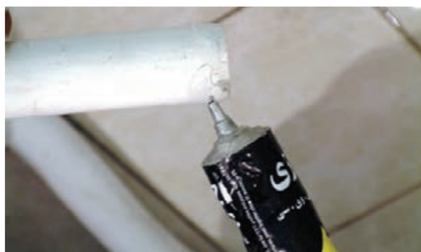
شکل ۳-۲۰۵- زدن چسب به لوله‌های تخلیه
