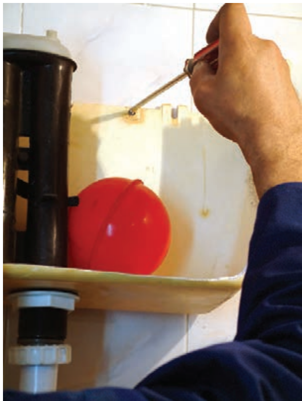
شکل ۲۱۳-۳- نصب مخزن فشاری به دیوار
