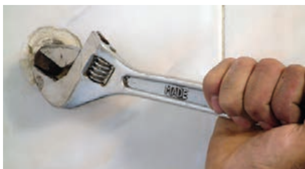
شکل ۱۹۸-۲ باز کردن درپوش‌ها
