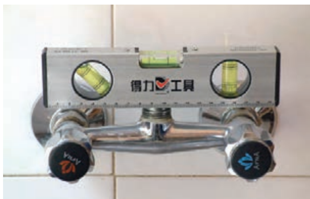
شکل ۱۷۴-۲ سنجش تراز بودن شیرمخلوط دیواری
