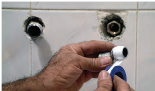
شکل ۱۹۹-۲ پیچیدن نوار تفلون به دور دنده‌ی \frac{1}{4} دنباله‌ی شیر مخلوط
