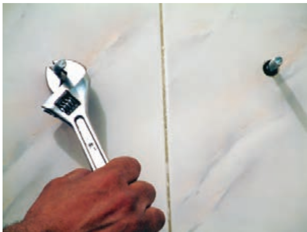
شکل ۳-۴۴- سفت کردن پیچ‌ها در درون رولپلاک‌ها
