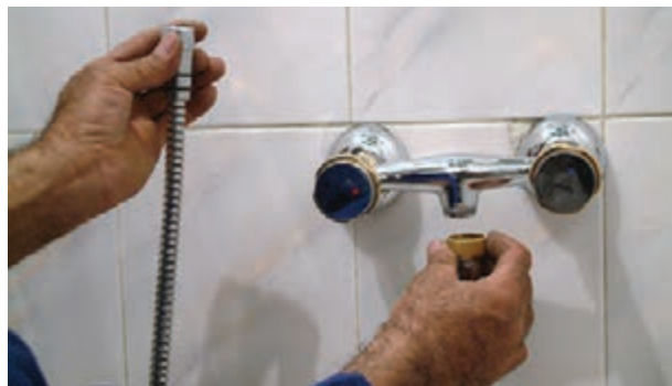
شکل ۲-۱۹۱- اتصال شیلنگ آفتابه به شیر مخلوط توالت
