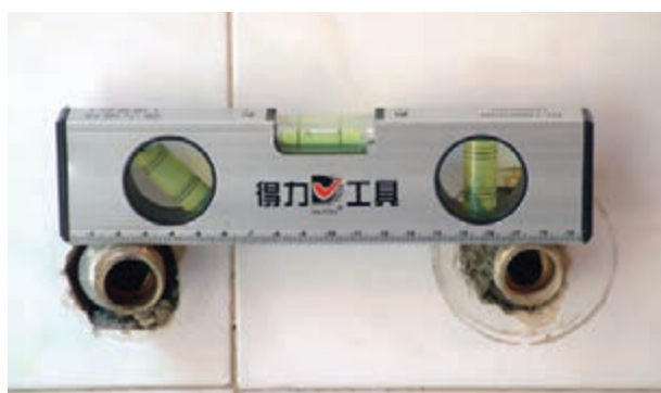
شکل ۲۰۳-۲- کنترل تراز بودن دنباله‌ها
