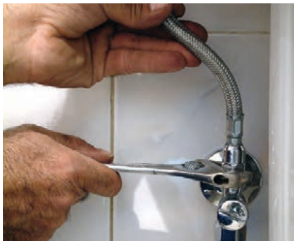
شکل ۳-۴۹ سفت کردن مهره‌های شیلنگ به شیر پیسوار
