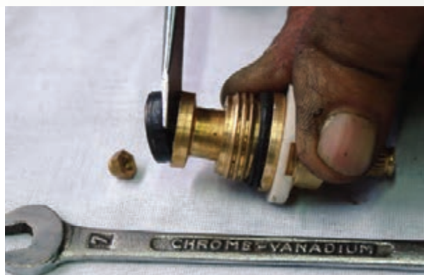
شکل ۲-۶۳- تعویض واشر
