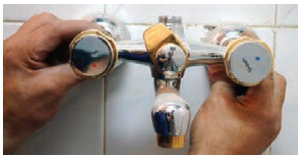
شکل ۲-۲۰۵- بستن مهره‌های شیر مخلوط دوش با دست
