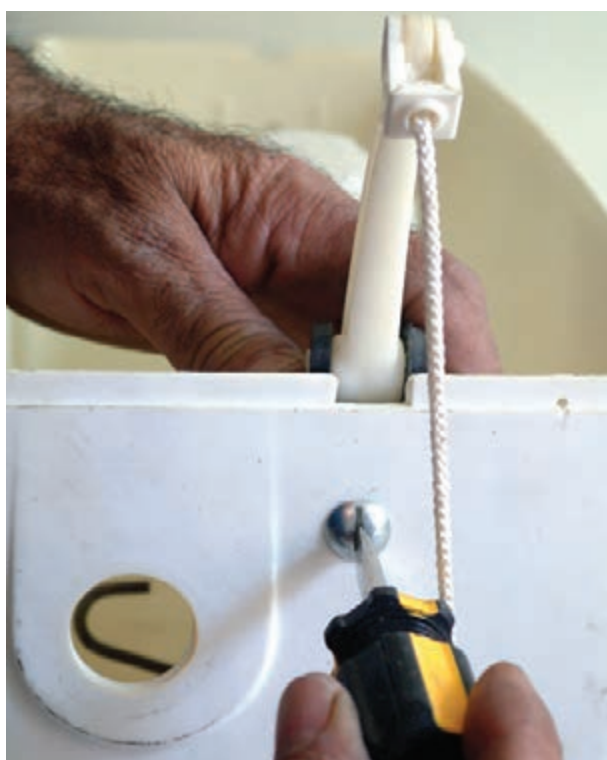
شکل ۳-۲۰۹- اتصال اهرم به بدنه‌ی مخزن فشاری
