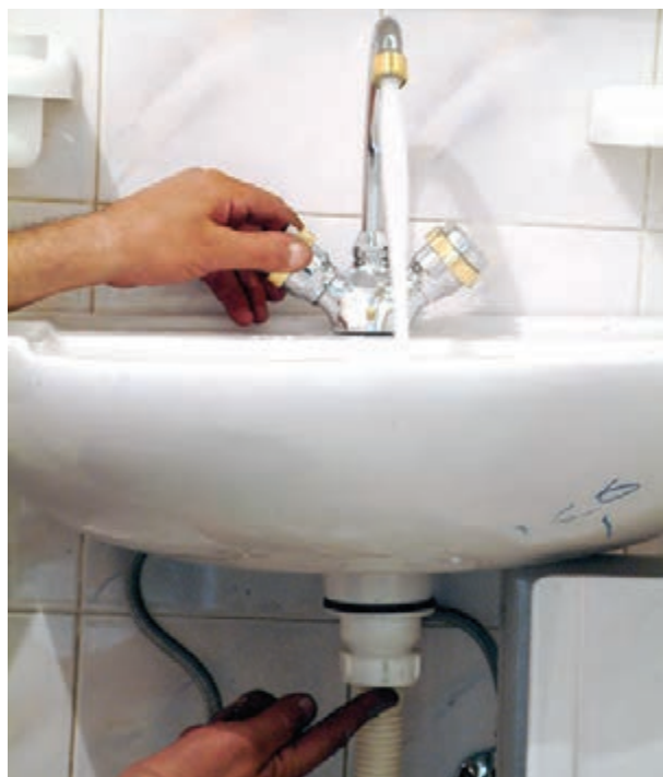
شکل ۳-۵۷ عمل کنترل نشت آب از محل‌های اتصال
