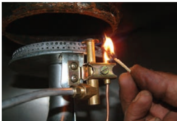
شکل ۱-۱۰۵ مشتعل کردن شمعک به وسیله‌ی شعله‌ی کبریت
