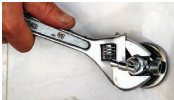
شکل ۲-۱۴۴- سفت کردن شیر پیسوار با آچار فرانسه
