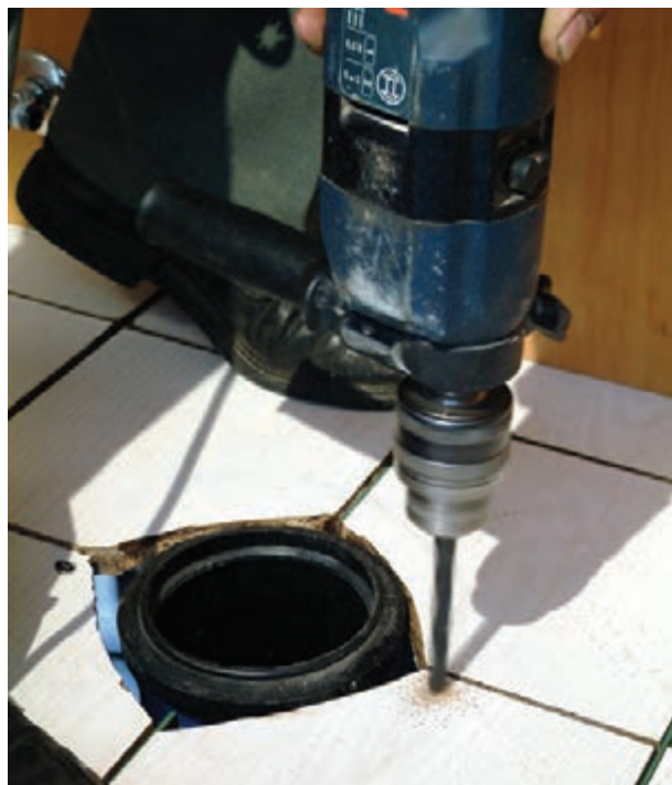
شکل ۲۴۶-۳- سوراخ‌کاری محل‌های علامت‌گذاری شده
