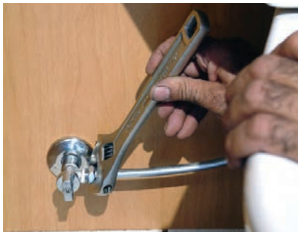
شکل ۳-۲۵۶- سفت کردن مهره‌ی شیر پیسوار
