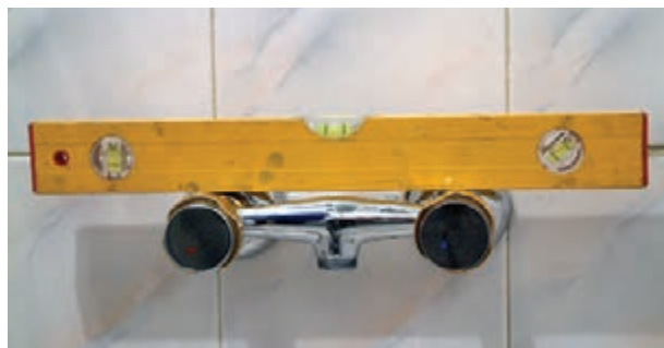
شکل ۲-۱۹۰- سنجش تراز بودن شیر مخلوط
