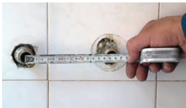
شکل ۲۰۲-۲- کنترل نمودن فاصله‌ی دنباله‌ها به وسیله‌ی متر
