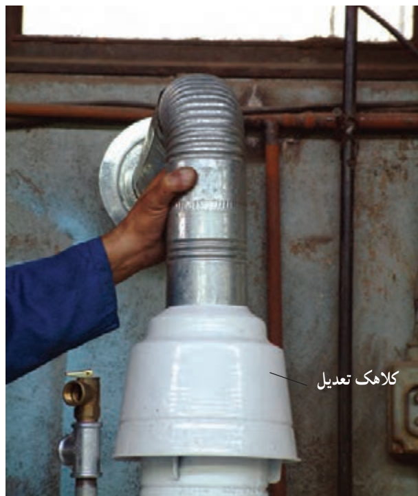
شکل ۹۳-۱- کلاhek تعدیل مورد استفاده در آب گرمکن های مخزنی گازسوز
