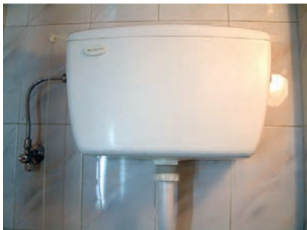
نصب مخزن فشاری
