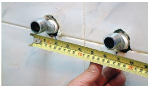
شکل ۱۶۸-۲ کنترل اندازه‌ی محور تا محور دنباله‌ها
