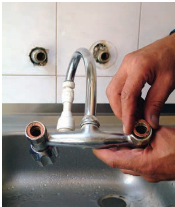
شکل ۲-۱۷۱- قراردادن واشر درون مهره‌ی تنه شیرمخلوط
