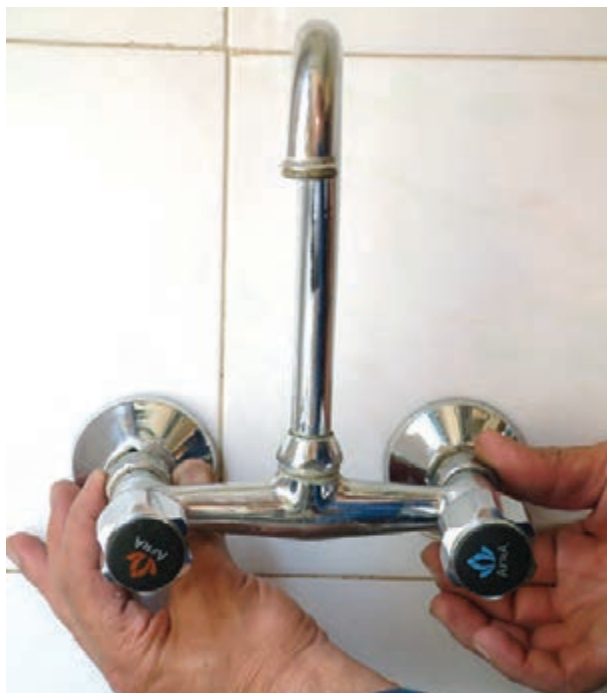
شکل ۱۷۲-۲ پیچیدن مهره‌ها به دنباله‌های شیر مخلوط
