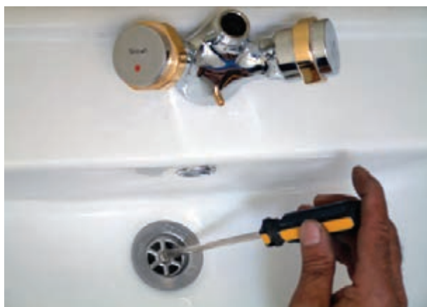
شکل ۳-۴۰ نصب زیراب بر روی دست شویی
