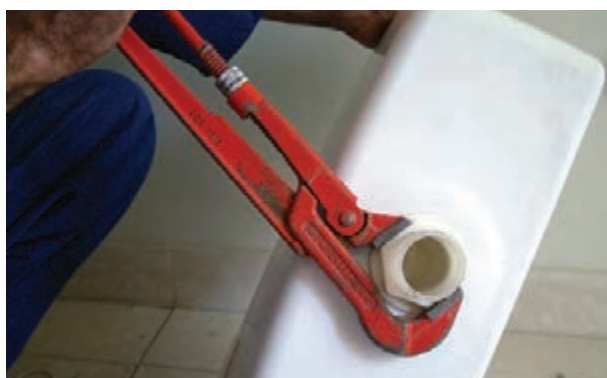
شکل ۳-۲۰۸- سفت کردن مهره‌ی پمپ تخلیه
