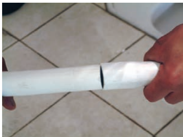
شکل ۳-۲۰۶- جا زدن لوله‌های تخلیه در درون یکدیگر
