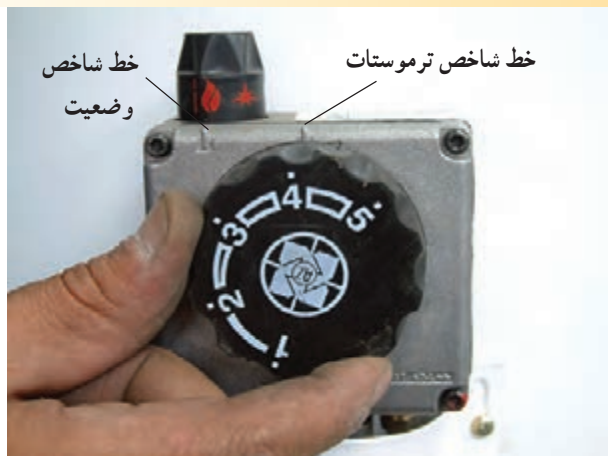
شکل ۱۱۰- تغییر کلید تنظیم دما (ترموستات)
