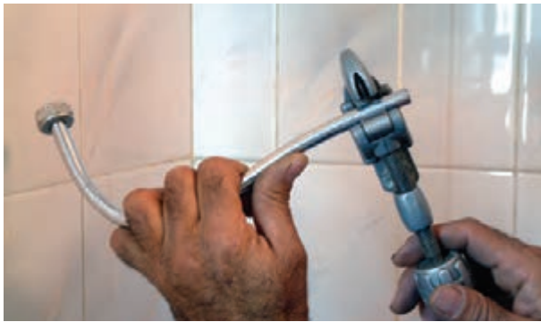
شکل ۲۲۲-۳- بریدن لوله‌ی پیسوار به وسیله‌ی لوله‌بر
