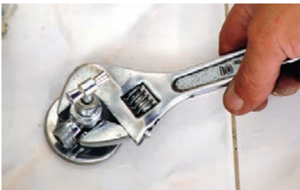
شکل ۳-۲۲۰- سفت کردن شیر پیسوار با آچار فرانسه
