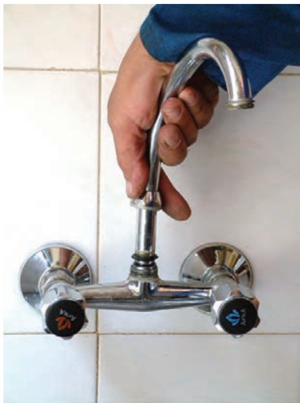
شکل ۱۷۵-۲- جازدن عَلم شیر مخلوط با دست در درون ناف شیر مخلوط
