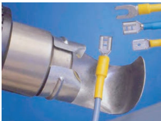
شکل ۷۹-۸- عایق کاری اتصال سرسیم به سیم
