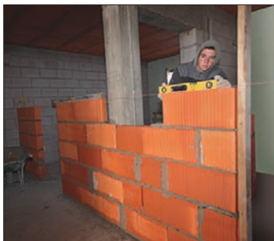
شکل ۱-۱۰۹ دیوار غیرباربر بلوک سفالی
