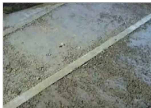
شکل ۲۱-۶ پرکردن فضای بین کرم‌ها با پوکة معدنی
