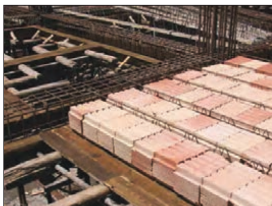
شکل ۱-۱۵۲ کاربرد بلوک سفالی در سقف
