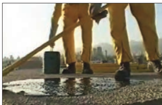
شکل ۲۲-۶ قیرگونی پس از پرکردن بین کُرْم‌ها
