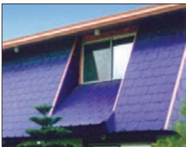
شکل ۴۷-۱ پوشش نهایی سقف شیب‌دار با آردواز
