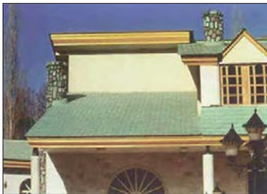
شکل ۱-۱۰۲ پوشش سقف با ورق‌های فشرده‌ی آردواز
