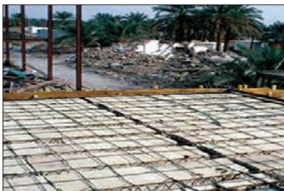
شکل ۱۳-۱ سقف تیرچه بلوک
