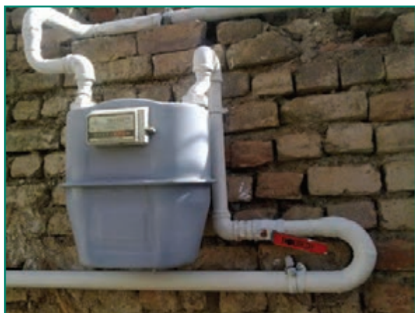
شکل ۸۱-۴ یک کنتور ۱۰ متری نصب شده
