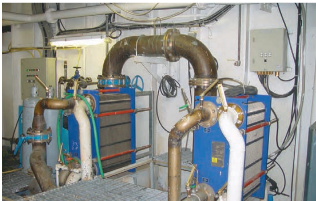
شکل ۶- سامانه خنک کاری آب دریا
