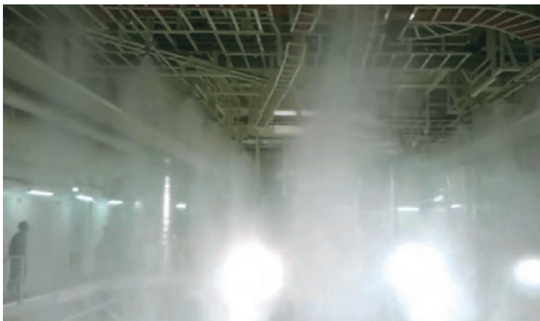
شکل ۱۶- عمل کردن حسگرها در موتورخانه یک کشتی
