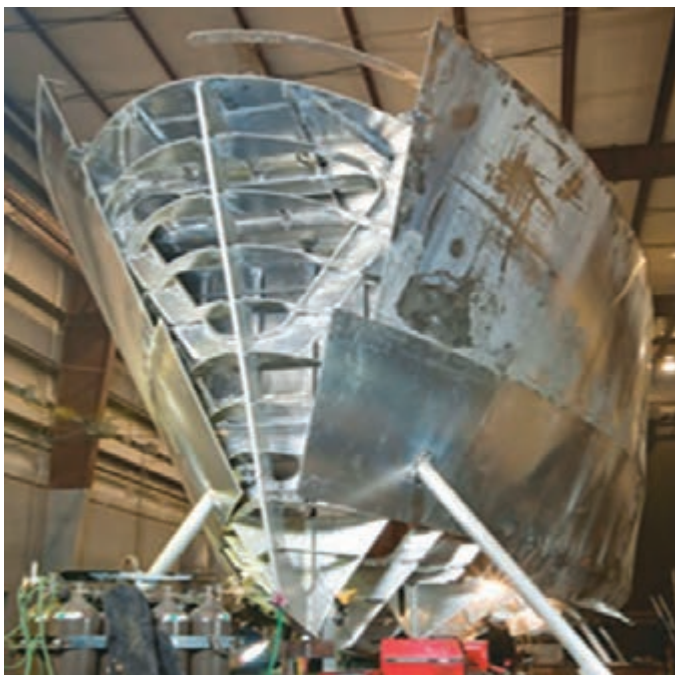
شکل ۲۳- سازهٔ سینهٔ یک شناور در حال ساخت
