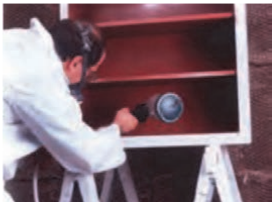
شکل ۲۳- رنگ کاری قسمت های داخلی
