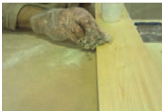
شکل ۶۶- زدن آب قبل از بتونه‌کاری
