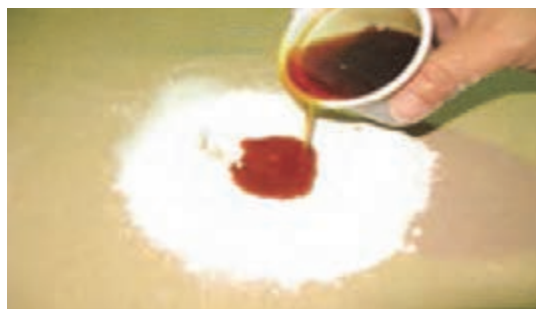
شکل ۸۶- اضافه نمودن رنگ روغنی به بتونه روغنی
