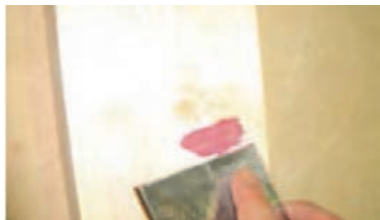
شکل ۹۳- لکه گیری قبل از ماستیک کاری
