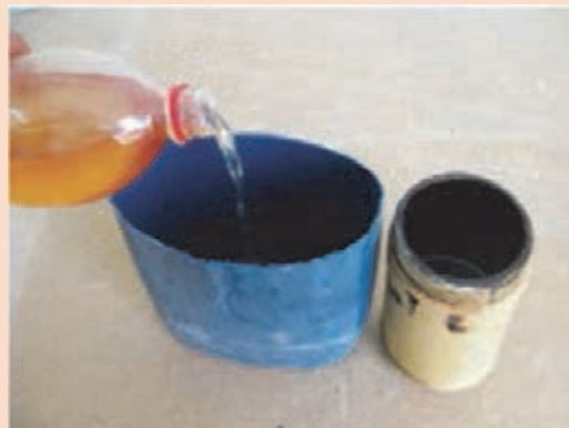
شکل ۷- رقیق کردن آستری قیری با بنزین
