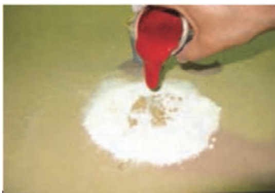
شکل ۷۹- اضافه نمودن روغن الیف به بتونه روغنی
