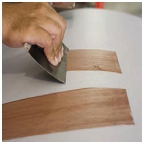
شکل ۲۶- ماستیک‌کاری
