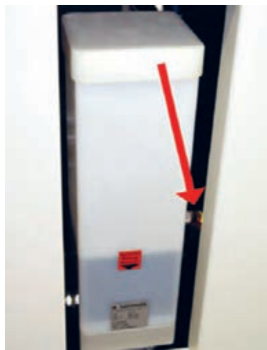
شکل ۱۳- حسگر تشخیص سطح روغن
