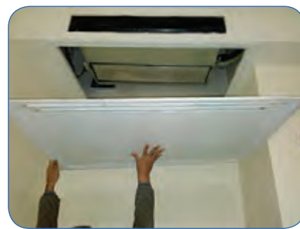
شکل ۱۴- نمونه دریچه دسترسی و برگشت هوا
