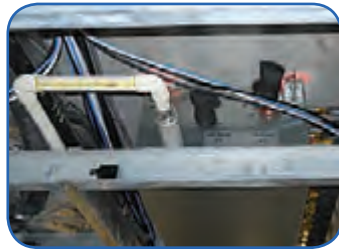
شکل ۸- نمونه اتصال لوله تخلیه به تشتک
