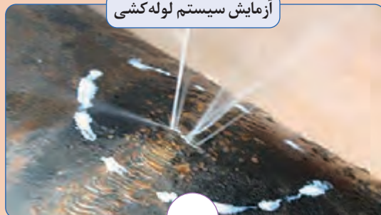
آزمایش سیستم لوله کشی
