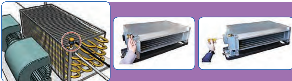
شکل ۲- هواگیری فن کویل
