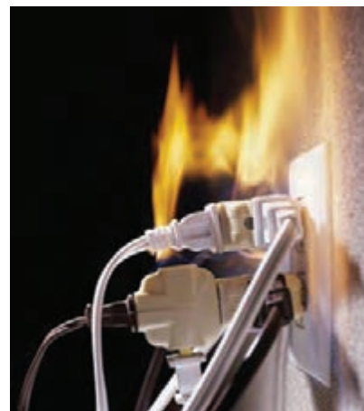
شکل ۹-۳ – آتش‌سوزی حاصل از ایجاد جرقه و سوختن سیم‌های برق
