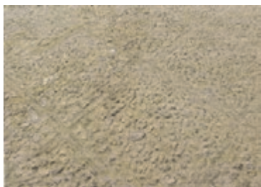
شکل ۲-۱۰۵- یزد، باغ دولت آباد، آژیانه
