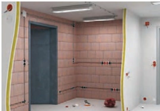
شکل ۳-۳۳- سیم‌کشی توکار
