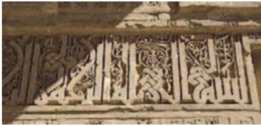
شکل ۶۲-۲- خراسان، آجر تراش، رباط شرف
