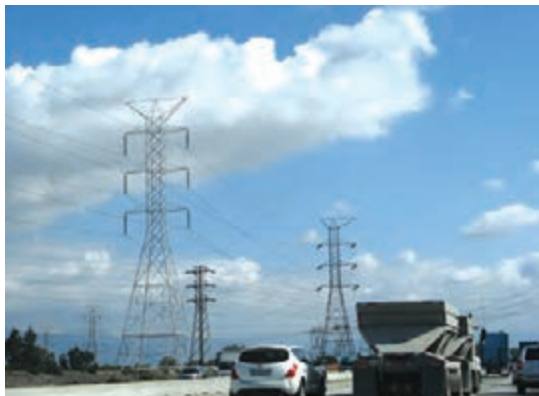
شکل ۵-۳- انتقال انرژی الکتریکی توسط دکل ها
