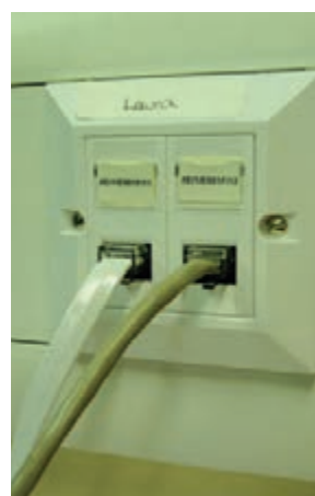
شکل ۲۶-۳- تصویر ظاهری و شمای فنی پریز تلفن
