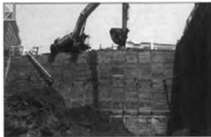
شکل ۱- ضرورت رعایت ایمنی در عملیات گودبرداری
