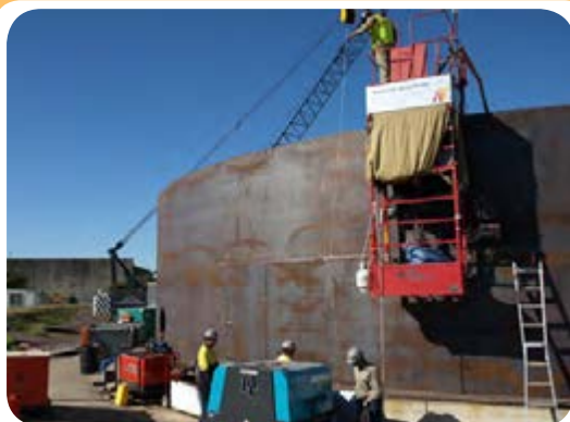
م) کارگاه ساخت مخازن ذخیره
