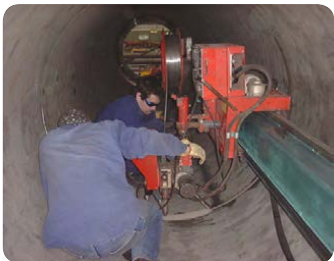
اتصال دو لوله فولادی با استفاده از فرآیند جوشکاری زیر بودری
