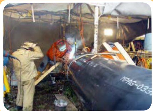
ن) کارگاه ساخت خط لوله
