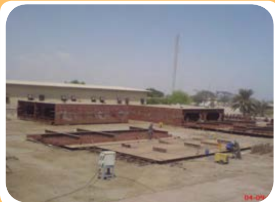
د) کارگاه ساخت اسکلت فلزی ساختمان
