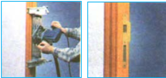
شکل ۱۶-۳۰- ایجاد شیار ممل استقرار برگه (روی جای زبانه قفل).
