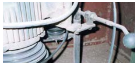
شکل ۳-۱۴- باز کردن درپوش (روی تسمه‌ها).
