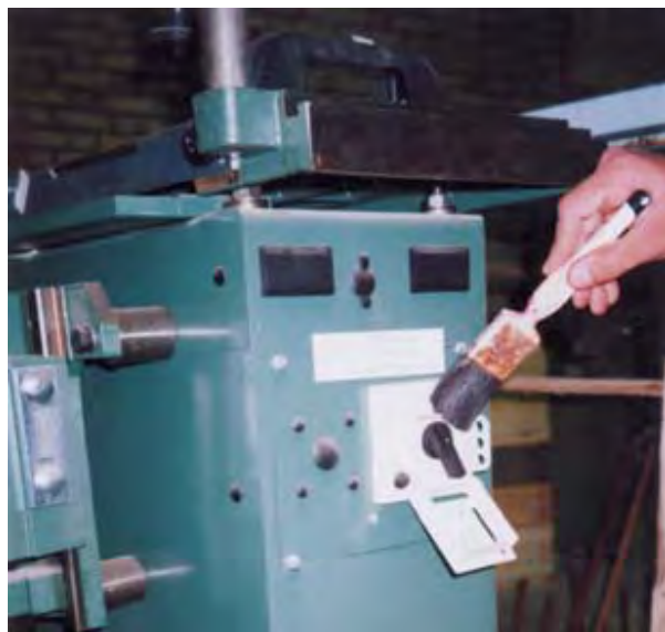
شکل ۱۰-۱۵- گردگیری و تمیز کردن کلید برق.
