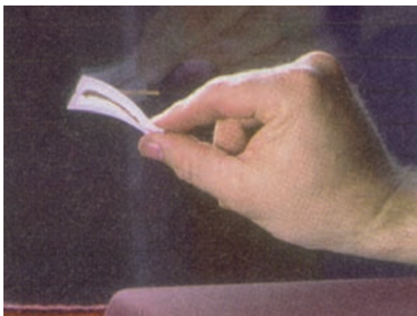
شکل ۲۶-۳- کندن نوار روی شیشه
