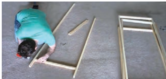
شکل ۱۹- ساخت قاب پارتیشن
