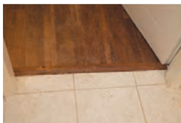
شکل ۹۲ تا ۹۴ - نصب لمینت در آستانه در
