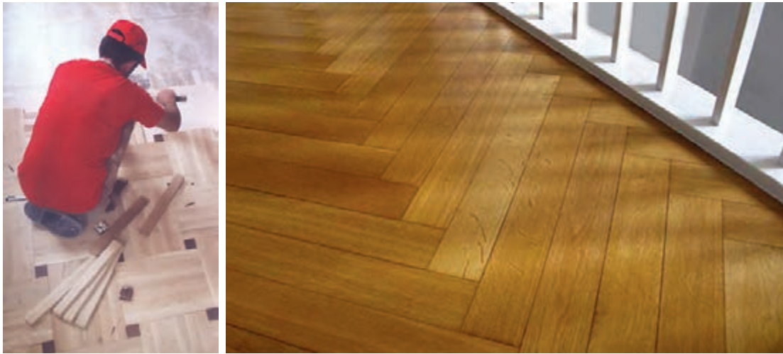
شکل ۷ و ۸- نمونه‌هایی از کف‌سازی با بلوک‌های چوبی
