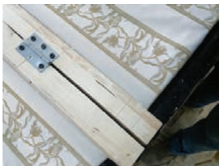
شکل ۷۵- دو پیچ بسته شده
