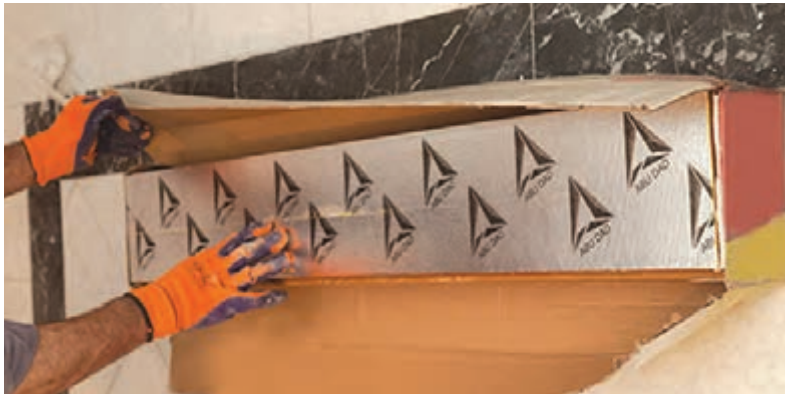
شکل ۱۸- لمینت به همراه لایه فوم در پشت آن
