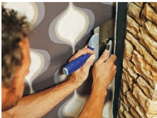
شکل ۸۵- برش اضافه پارچه روی دیوار
