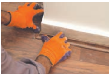
شکل ۹۲ تا ۹۴ - نصب لمینت در آستانه در
