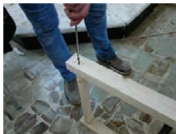
شکل ۵۶- بستن پیچ با پیچ‌گوشتی دستی
