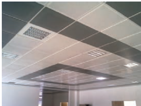
شکل ۱- اجرای سقف کاذب با مواد صداگیر
