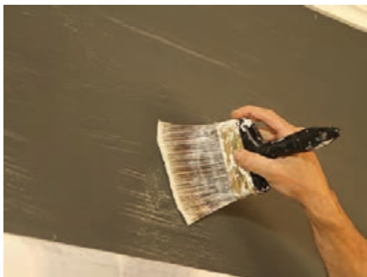
شکل ۸۴- چسب زدن دیوار
