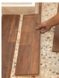
شکل ۹۰ و ۹۱ - قفل کردن قطعات لمینت به یکدیگر
