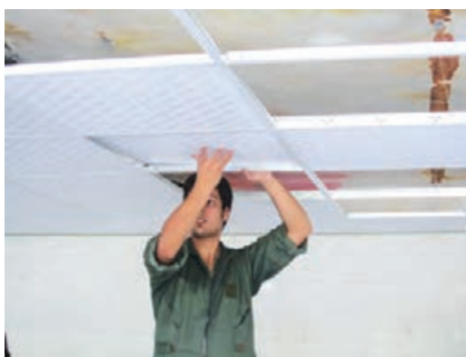
شکل ۱۷- نصب و تنظیم پنل در شبکه فلزی
