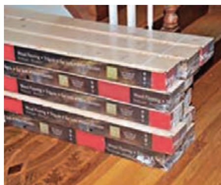
شکل ۲۶ و ۲۷- نحوه قرار دادن درست جعبه های لمینت
