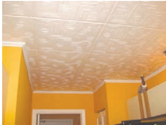
شکل ۳- اجرای سقف کاذب با فوم
