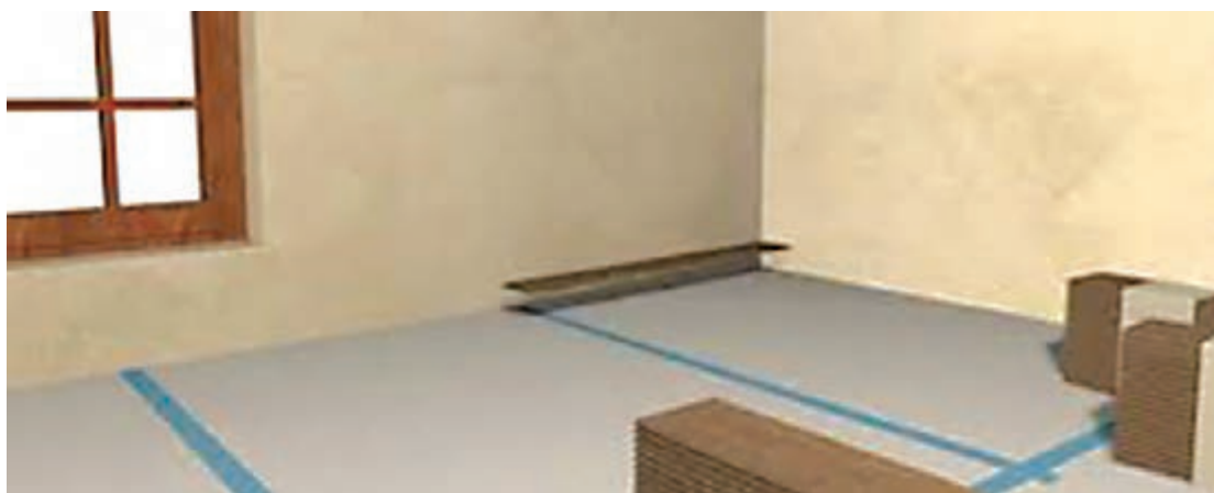
شکل ۲۴ - پوشش کامل کف با فوم صدا گیر
