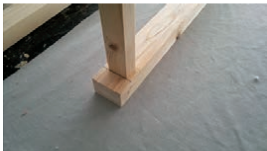
شکل ۴۷- استقرار قید افقی بر روی قید طولی
