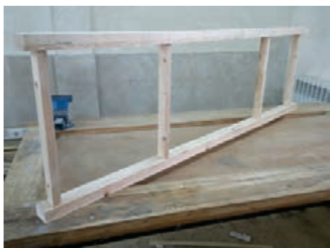
شکل ۵۲- اتصال موقت قطعات پاراوان
