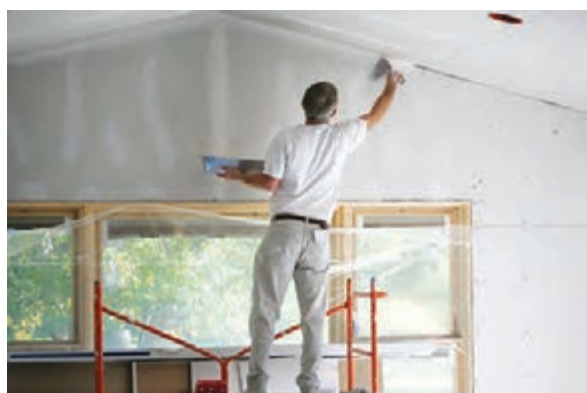
شکل ۱۸- پرداخت درز بین دیوار و سقف کاذب
