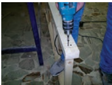
شکل ۵۷- بستن پیچ با دریل
