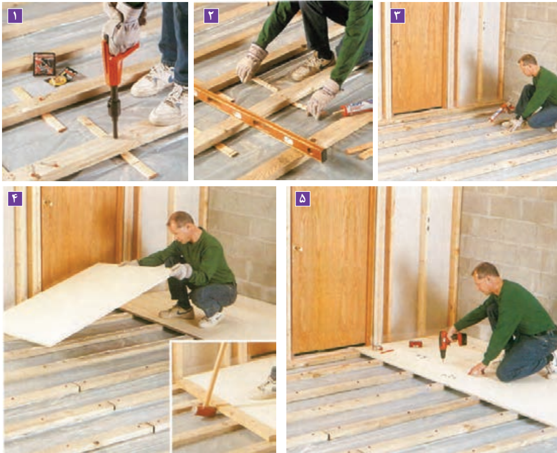
شکل ۴- مراحل نصب کف با تخته چوبی
