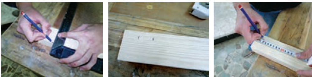
شکل ۴۲- اندازه‌گیری و خط کشی محل قید بالای پاراوان
