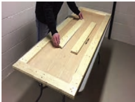
شکل ۴۲- نوارهای چوبی لبه تخته با فیتینگ های نصب
