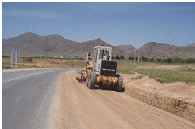
شکل ۴۰- احداث جاده و حریم آن در زمین کشاورزی
