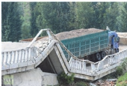
شکل ۱۳- تخریب رویه روسازی و ابنیه فنی
