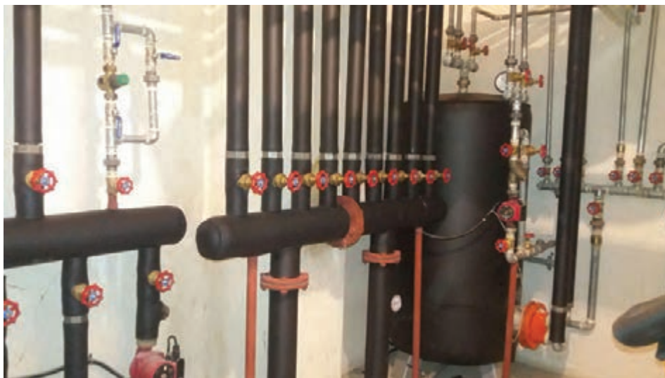
شکل ۲۵- عایق کاری در موتورخانه
