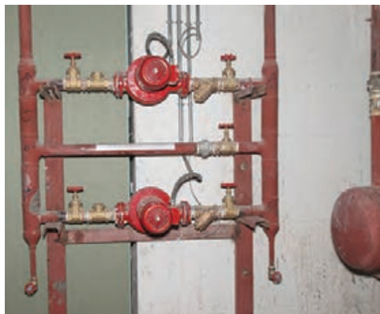
شکل ۲۴- اتصال شیر تخلیه
