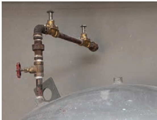
شکل ۲۳- اتصال لوله هواگیری مخزن
