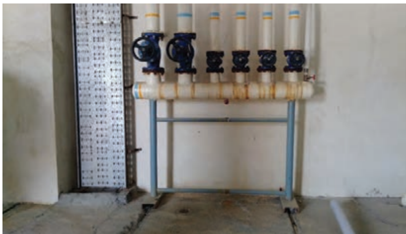
شکل ۲- نصب پایه کلکتور
