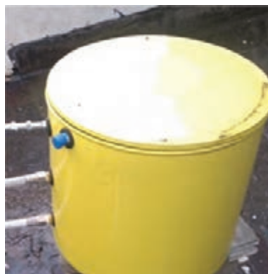
شکل ۳- مخزن انبساط باز با عایق
