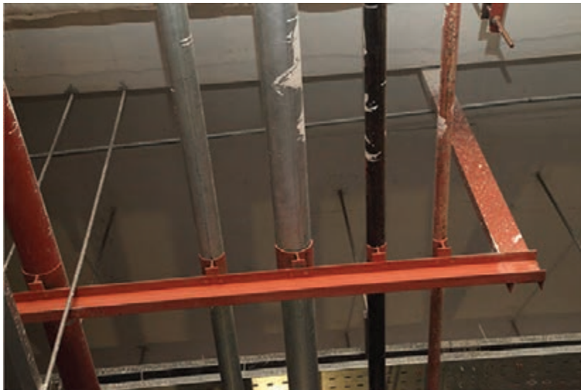
شکل ۱۶- آویز چند لوله‌ای
