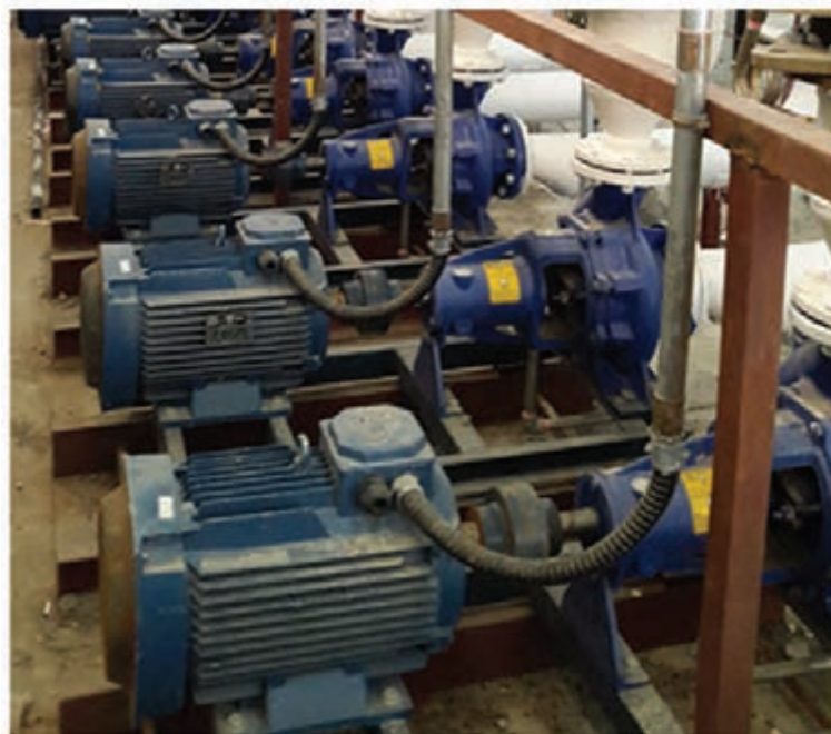
شکل ۲۴- اتصال موتورهای سه فاز
