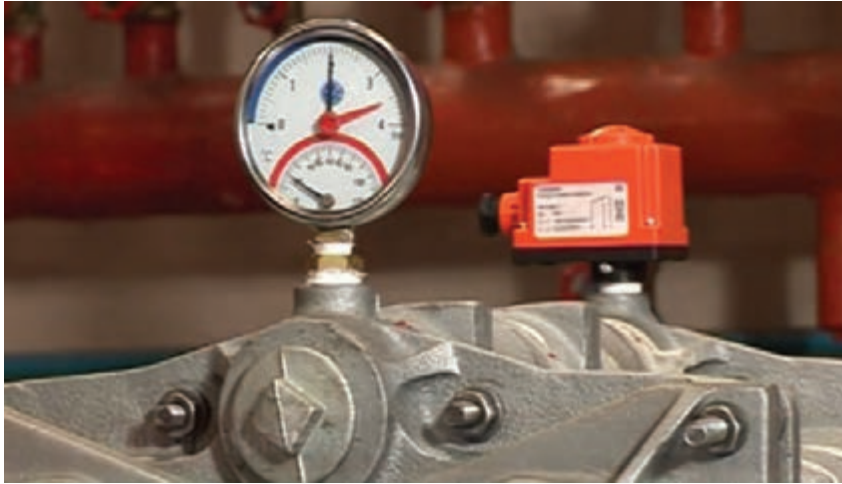
شکل ۲۱- نصب کنترل کننده و نشان دهنده دیگ
