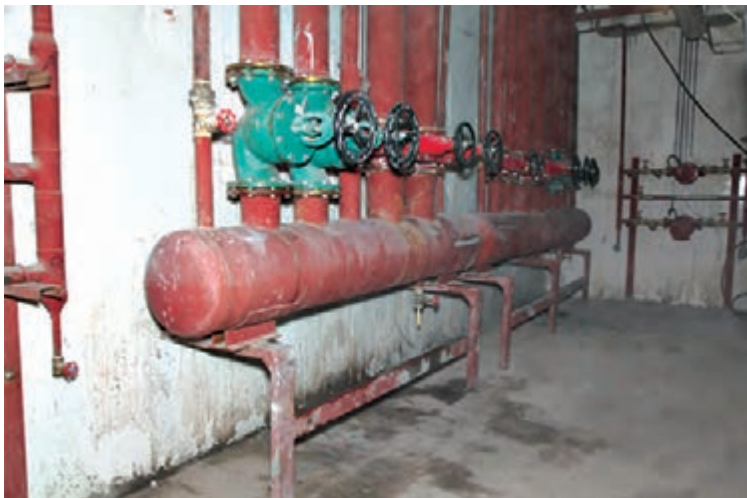
شکل ۱- نصب شیر تخلیه کلکتور
