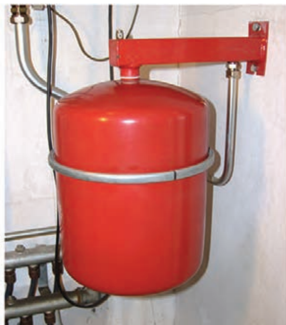
شکل ۱۶- استقرار مخزن انبساط بسته
