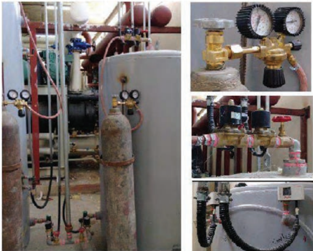
شکل ۲۳- مخزن انبساط بسته با متعلقات
