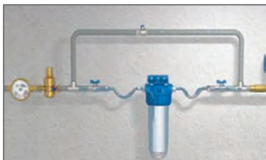
شکل ۶ - روش نصب سختی گیر پلی فسفات
