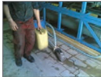
شکل ۲۵- مسیر ارتباطی پمپ و شلنگ به مبدل و بشکه اسید (پراتور آماده افزودن دیسکیلر به بشکه است)
