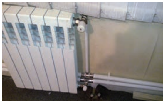
شکل ۶۱- اتصال سر لوله رادیاتور روکار
