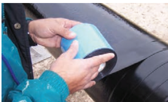
ب) نحوه پیچیدن نوار
