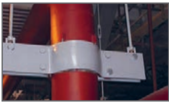
شکل ۱۸- تکیه‌گاه لوله قائم
