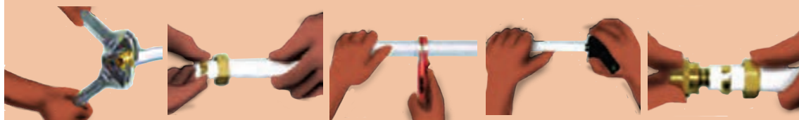
شکل ۴۴- مراحل اتصال لوله پکس
