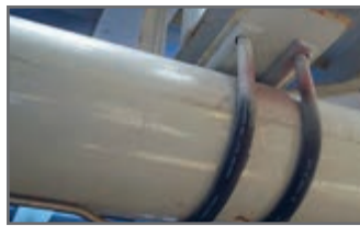
شکل ۱۷- تکیه‌گاه لوله افقی
