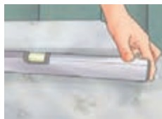
۴- با استفاده از تراز از مسطح و صاف بودن سطح فضا اطمینان حاصل کنید.
