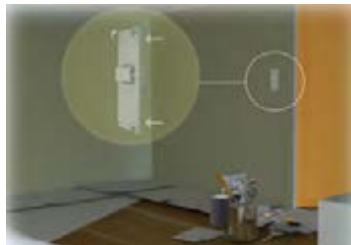
۲- قفل‌ها و دستگیره‌ها، کلیدها، پریزهای روی دیوار و سقف را حتی المقدور باز کنید.
