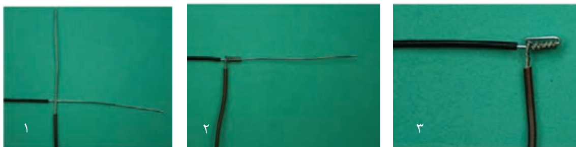
شکل ۱-۵۲- اتصال سیم افشان به سیم مفتولی
