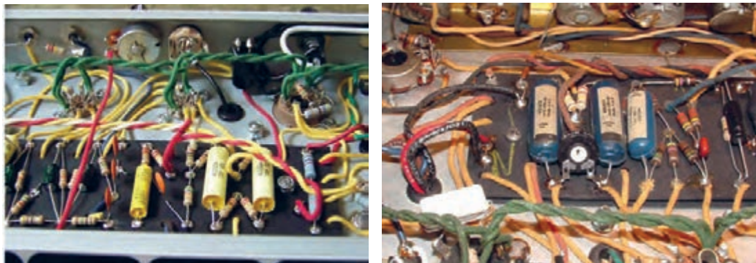
شکل ۵-۱-۱ - نصب قطعات الکترونیکی در دستگاه های قدیمی
