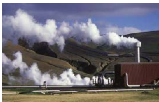
شکل ۱۱-۱۲- نیروگاه زمین گرمایی
