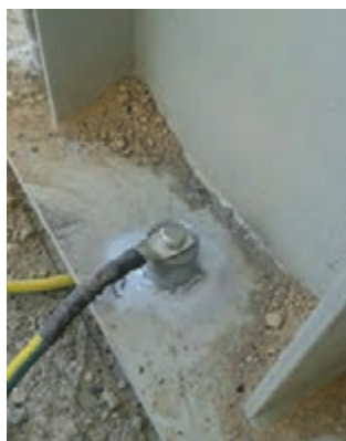
شکل ۲۴- اتصال اسکلت فلزی پیچی
