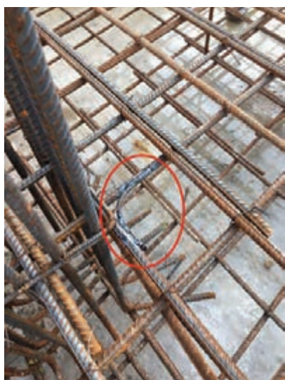
شکل ۲۰- جوشکاری میلگردها در گوشه
