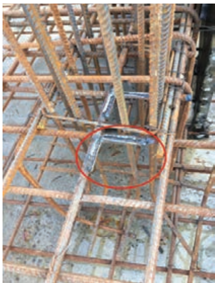
شکل ۱۹- جوشکاری میلگردها در یک تقاطع چهارراه
