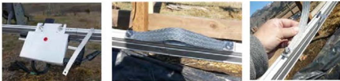
شکل ۲۹- همبندی در سامانه فتوولتائیک
