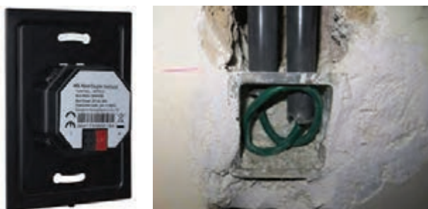
شکل ۴۰- عبور کابل Knx از لوله به صورت کلید به کلید
