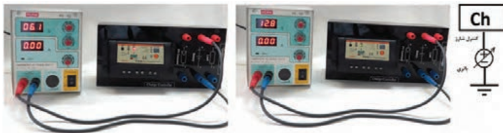
شکل ۱۸- تست کنترل شارژ
