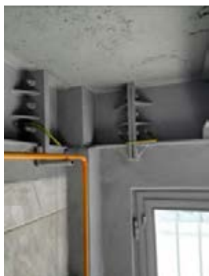
شکل ۲۴- اتصال اسکلت فلزی پیچی
