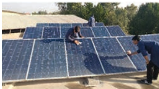
شکل ۴- تمیز کردن مدول‌های خورشیدی
