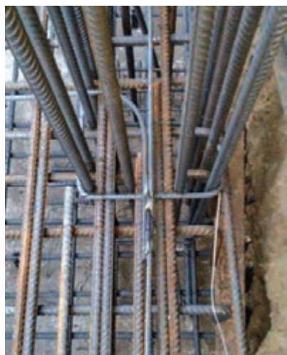
شکل ۲۲- جوشکاری میلگردهای شناژ با شالوده
