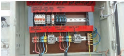
شکل ۶۴- نصب سرچ ارستر
