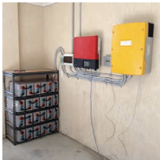
شکل ۶۱- اتصالات سیستم فتوولتائیک
