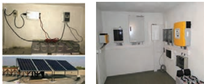
شکل ۴۶- اجرای دو نمونه سیم‌کشی سیستم فتوولتاییک
