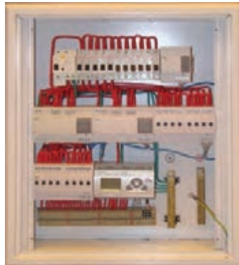
شکل ۵۳- دو نمونه تابلوی توزیع برق (DP)
