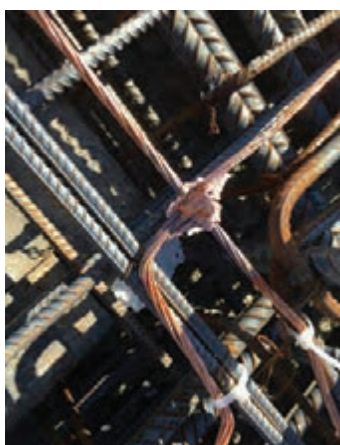
شکل ۱۲- جوش احتراقی سیم مسی
