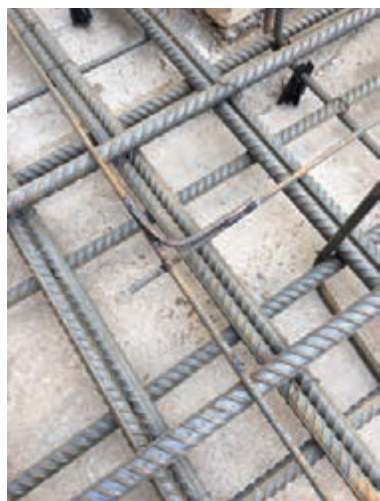
شکل ۲۱- جوش کاری میلگردها در تقاطع سه راهه
