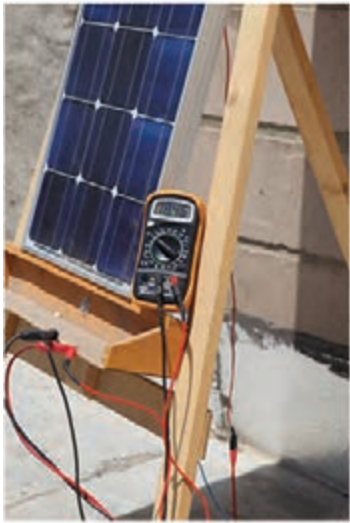
شکل ۱۵-۱ اندازه‌گیری ولتاژ بی‌باری
