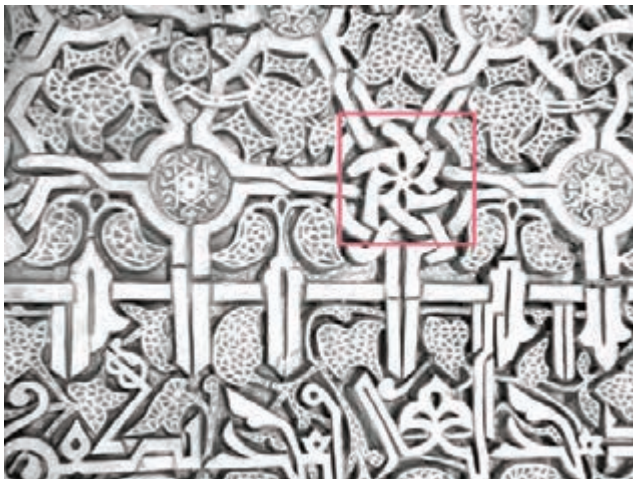
شکل ۳۳-۶. بخشی از گجبری مسجدی در ارومیه
