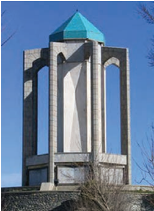
▲ شکل ۶-۱۴- آرامگاه باباطاهر، همدان، محسن فروغی
