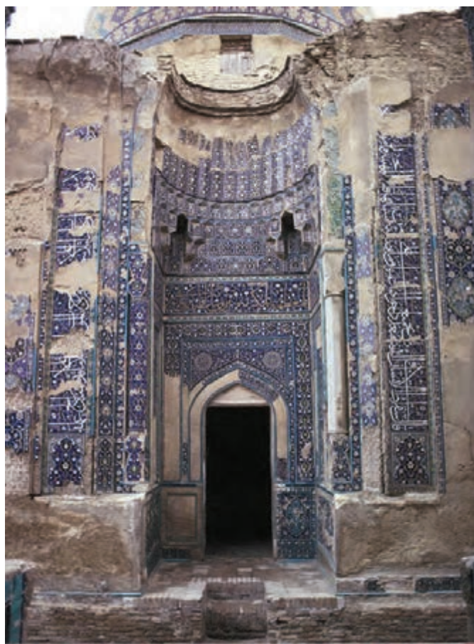
▲ شکل ۱۱-۱۱- کاشی‌کاری، مسجد کبود، تبریز
