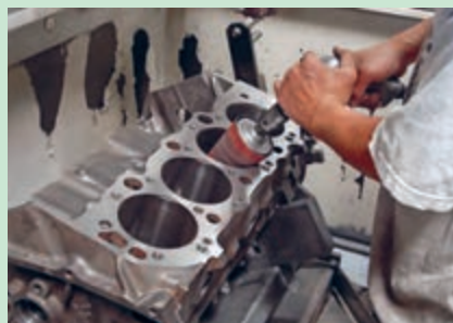
شکل ۳۹. ترمیم لبه بالای سیلندر
