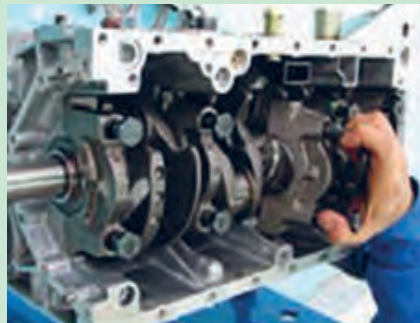
شکل ۴۸. برداشتن کپه های یاتاقان و چیدن آنها
