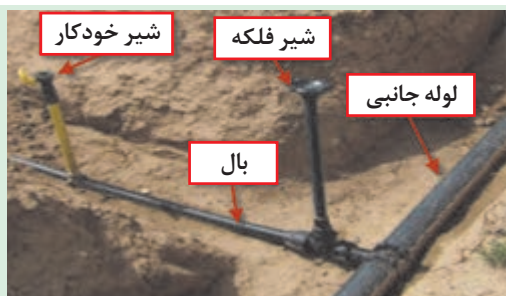
شکل ۱۳-۵. محل شیر فلکه روی بال
