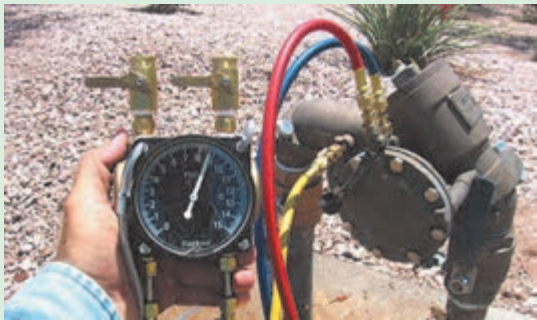
شکل ۳۱-۵. تنظیم فشار شیر فشار شکن
