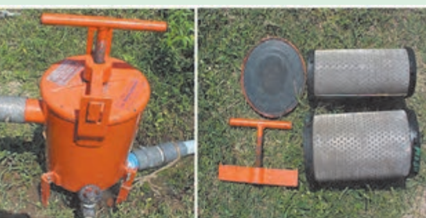
شکل ۵۷-۵. قطعات باز شده صافی توری
