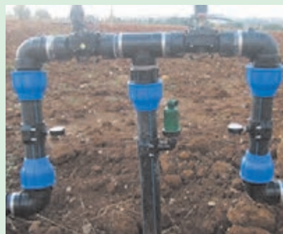
شکل ۳۲-۵. شیر و فشار سنج روی بال ها
