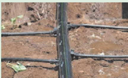
شکل ۱۸-۵. ردیف نوارهای روی لوله
