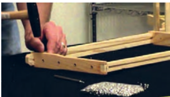
سوراخ کردن و میخ‌کوبی قاب
