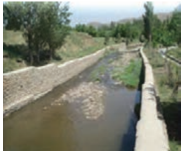
شکل ۱-۶۴- دیوار حاشیة رودخانه
