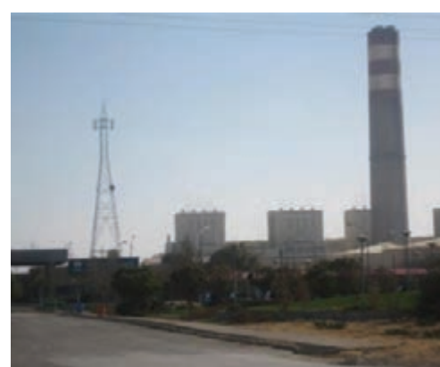
شکل ۱۹-۵- نیروگاه برق شهید مفتاح - فامنین
