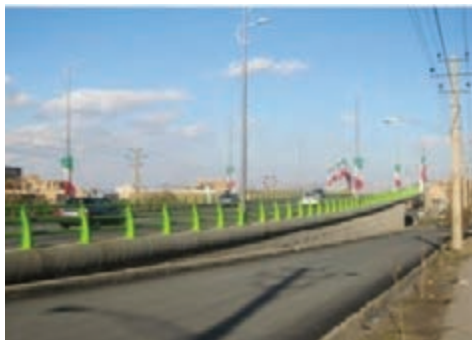
شکل ۱۰-۶- پل روگذر رسالت - همدان
