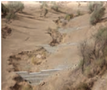
شکل ۱-۶۳- بند گابیونی (سنگ‌ها در تور سیمی)
