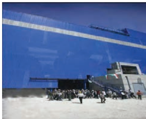
شکل ۱۸-۵- مجتمع فولاد ویان - کبودرآهنگ
