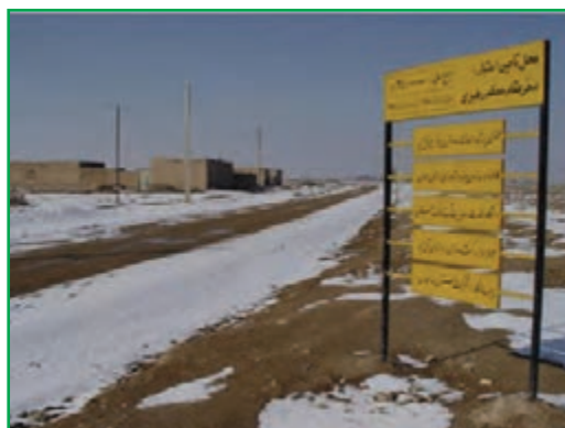
شکل ۶-۶- پروژه احداث راه روستایی - آق تپه
