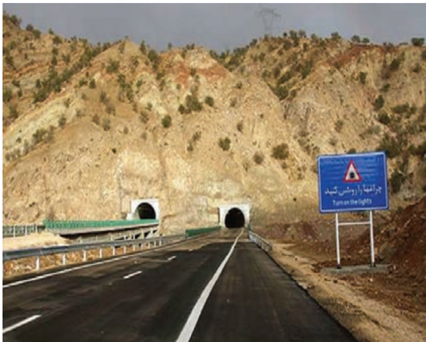
شکل ۱۲-۱۴- آزادراه خرم‌آباد - پل زال
