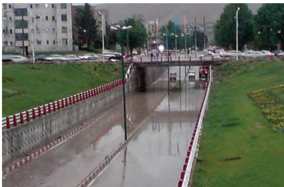
شکل ۱۰-۱۴- یکی از زیرگذرهای شهر خرم‌آباد
