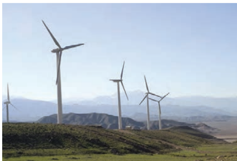
شکل ۲۷-۵- نیروگاه برق بادی منجیل
