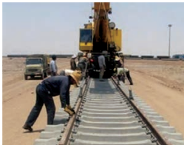
شکل ۱۵-۶- مراحل ساخت راه آهن قزوین - رشت - آستارا
