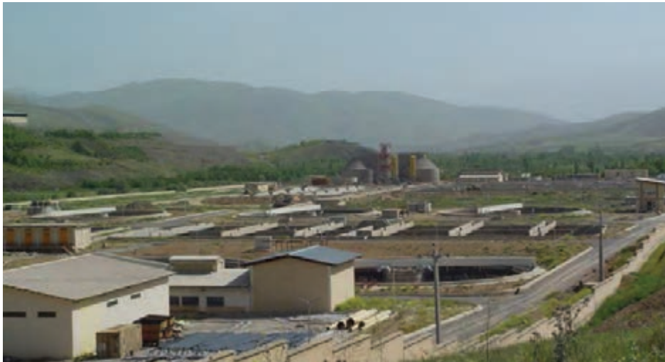
شکل ۷۳-۱- تصفیه‌خانه فاضلاب سنندج
