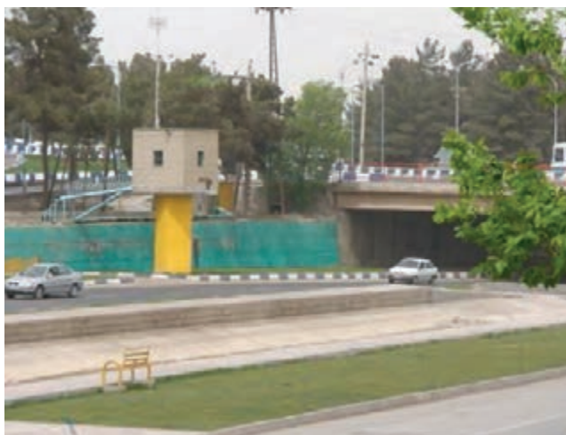
شکل ۱۸-۱- تصویر یکی از چاه‌های آب داخل رودخانه
