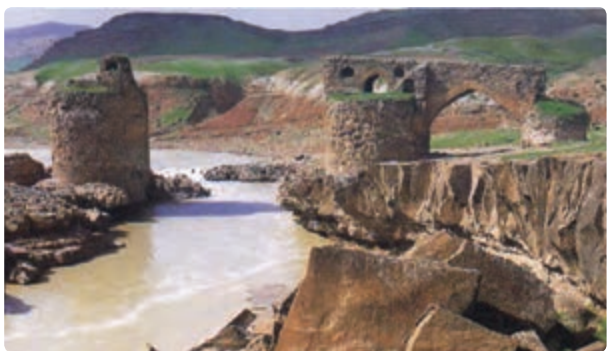
شکل ۲۹-۵- پل گاومیشان دره شهر
