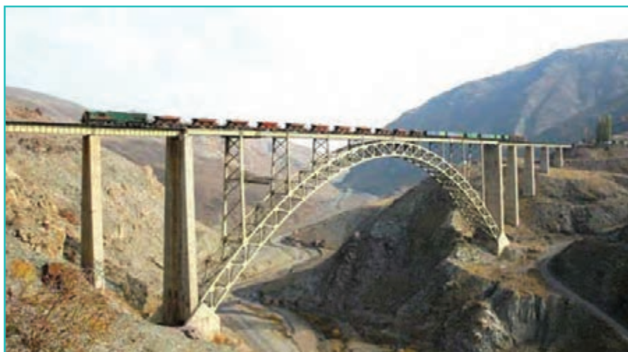
شکل ۲۷-۴- پل هوایی بر روی رود قطور (قطورچای) - خوی
