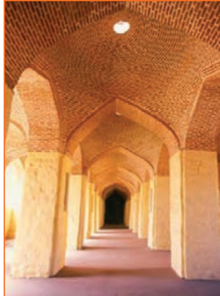
شکل ۲۳-۴- نمایی از داخل مسجد جامع ارومیه
