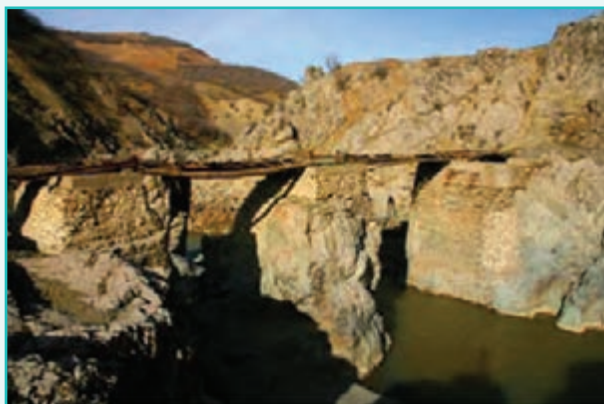
شکل ۲۷-۵- پل قالاتاسیان سردشت
