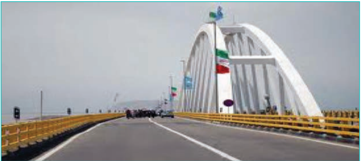
شکل ۶-۶- پل میان گذر دریاچه ارومیه
