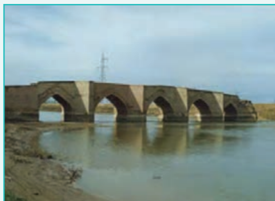
شکل ۲۶-۵- پل میرزا رسول در میاندوآب
