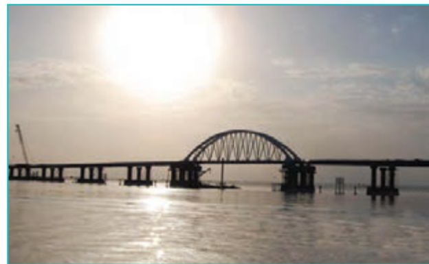
شکل ۱۲-۵- بزرگراه شهید کلانتری بر روی دریاچه ارومیه
