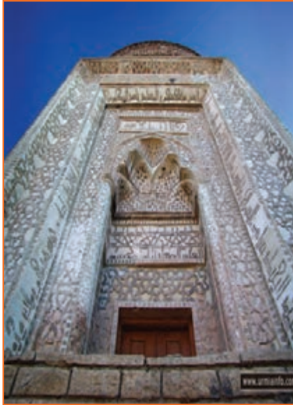
شکل ۲۴-۴- نمایی از سه گنبد ارومیه
