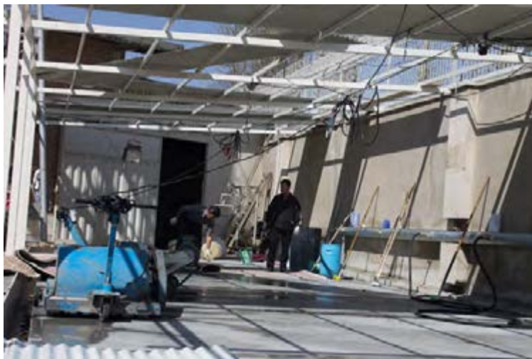
تصویر ۵- سالن شور در فضای بیرونی کارخانه ▲
