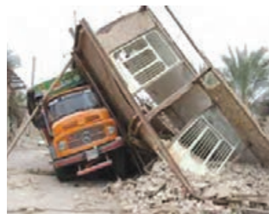
الف) ریزش دیوار در اثر زلزله
