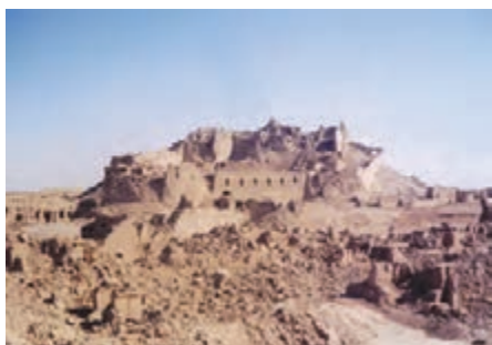
ج) ارگ بم بعد از زلزله
