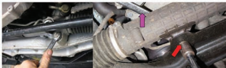
شکل ۲۰ - سفت کردن اتصالات جعبه فرمان
