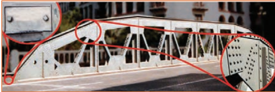
شکل ۳- اتصال دائم : پرچ
