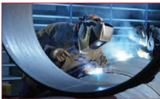
شکل ۵-۱- جوش کاری مخزن فولادی
