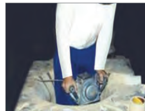
شکل ۱۳- کوبیدن نسوز کف کوره با کوبه ماشینی
