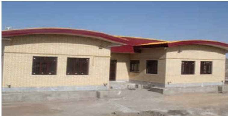
شکل ۳۲ - نمایی از یک راهدارخانه
