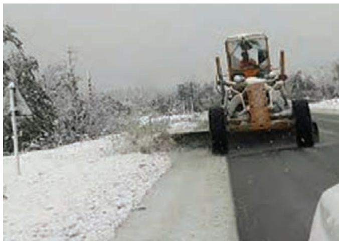
شکل ۷- گریدر در حال انتقال برف از سطح جاده به کناره مسیر
