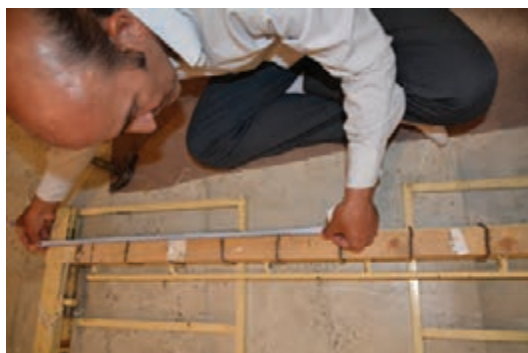
شکل ۱۸-۵ - نشانه‌گذاری بر روی چوب پایین‌کشی
