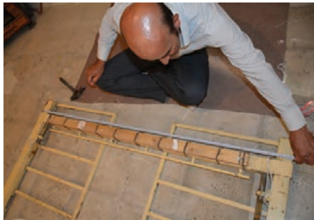
شکل ۱۶-۵ - نصب چوب پایین کشی پشت زیردار
