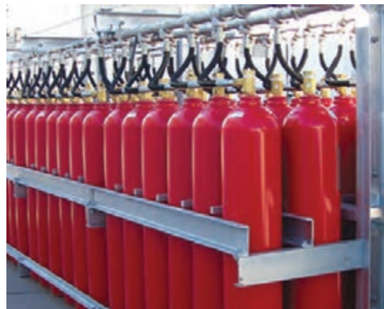
شکل ۳۸- سامانه اطفای حریق CO 2
