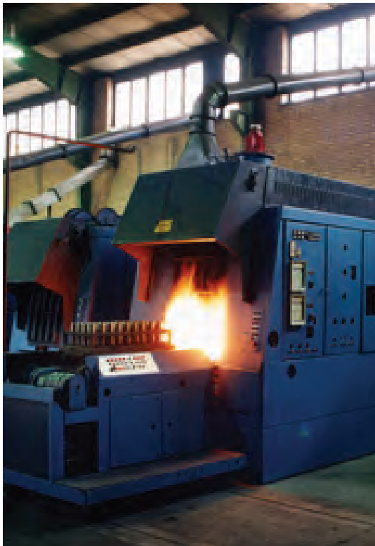
شکل ۳۱- کوره کربورایزینگ گازی
