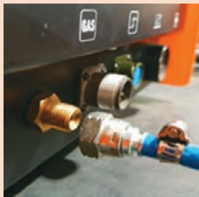
شکل ۶- نصب اتصال گاز محافظ
