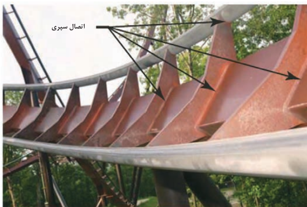
شکل ۱۲- کاربرد اتصال سپری
