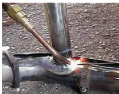
شکل ۱۱- جوشکاری استیلن
