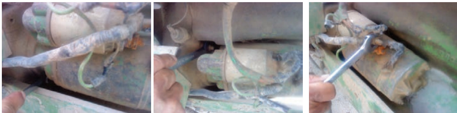
شکل ۵۰-۶- باز کردن کابل مثبت از استارت
