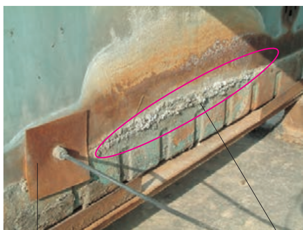
رسوب های آب تعمیر غیراساسی شکل ۸-۱۷۶
