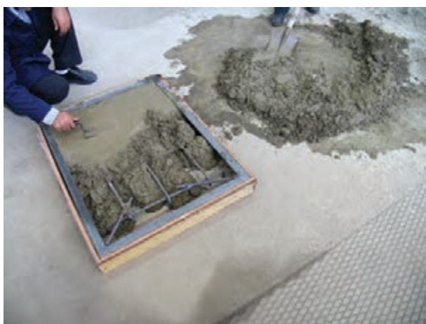
شکل ۶-۱- پر کردن قالب با ملات مناسب
